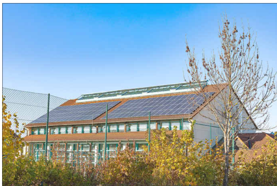
In der Sitzung im Juli wurde dem Gemeinderat ein Konzept über die Ausstattung von weiteren gemeindlichen Dachflächen mit Solaranlagen vorgestellt. Im Bild: Die bereits seit 2006 bestehende PV-Anlage auf der Mehrzweckhalle. Fotos (2): VG Heßdorf/Brehme
