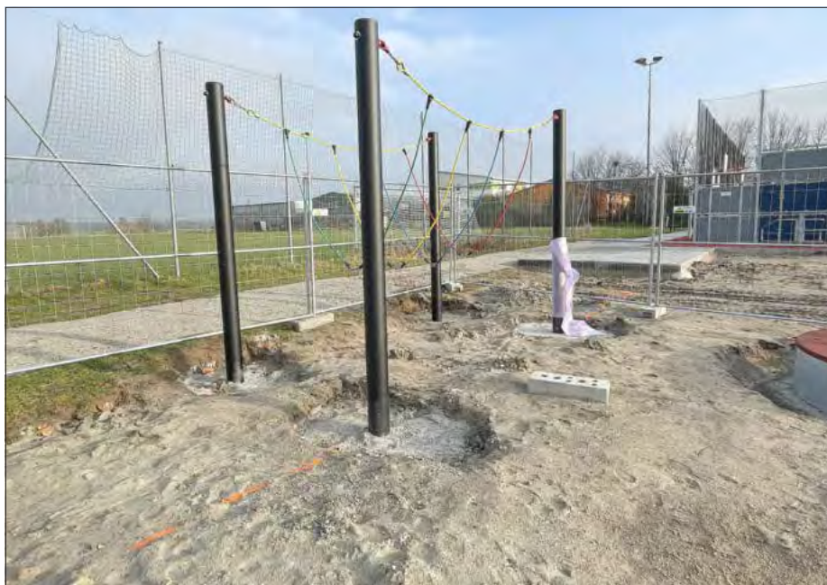
Das Gerüst der Tampenschaukel steht bereits. Das Tau auf dem die Kinder schaukeln können wird im neuen Jahr montiert. Foto: Monika Voigt/VG Heßdorf
