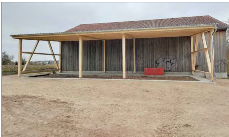
Die neue Kalthalle hat einen Anbau erhalten.
