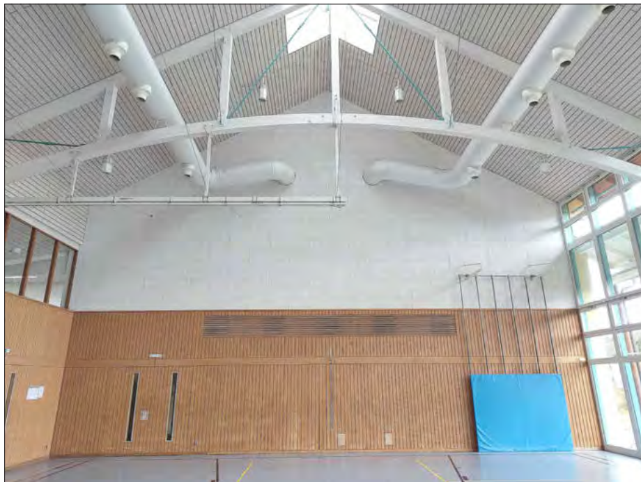
Für einen besseren Klang sorgen die neuen Akustikplatten in der Mehrzweckhalle.
