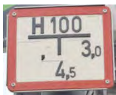
Hydranten-Hinweisschilder müssen stets gut sichtbar sein und daher ggf. von Bewuchs freigeschnitten werden.
